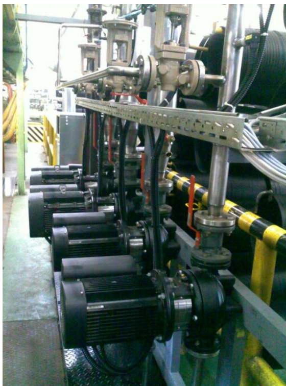
Slika 5.27: Črpalke hladilne linije
