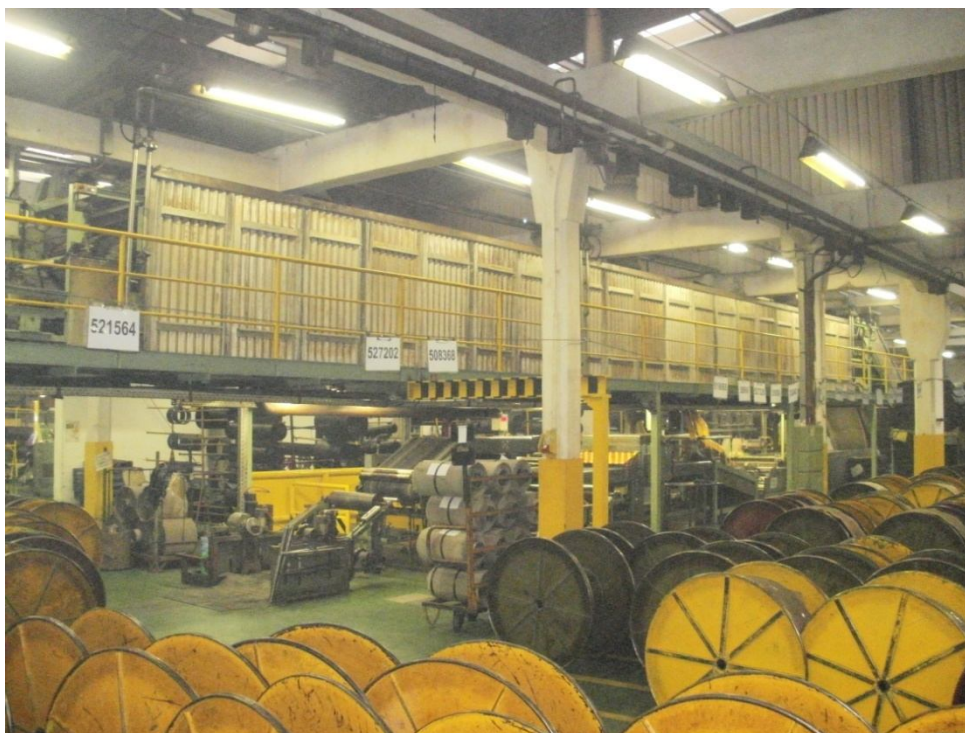
Slika 3.14: Zgornji hladilni kanal
